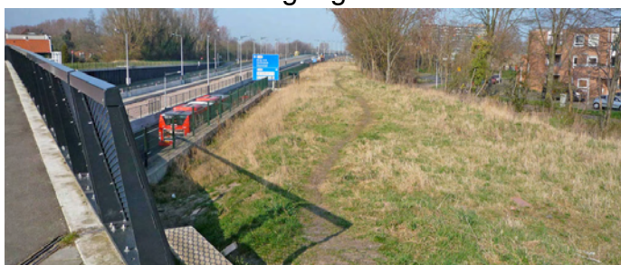
Kaagmanpad vanaf het viaduct gezien. Aan de overkant van de NLW loopt de bouwweg.
